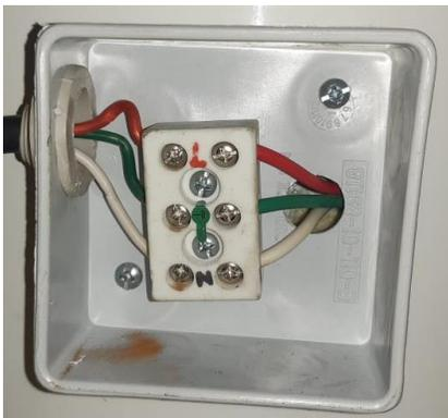
Para conectar el termo a la red eléctrica se debe retirar la tapa de la caja eléctrica ubicada en la parte inferior del artefacto (caja blanca sobrepuesta), en su interior se verán los bornes de conexión en loza.
